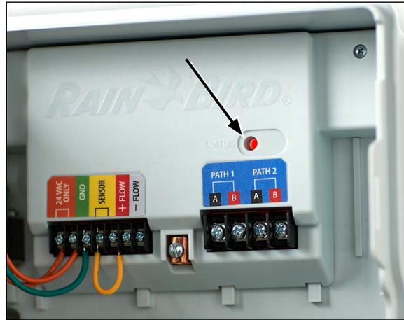
Painel posterior do programador ESP-2WIRE
