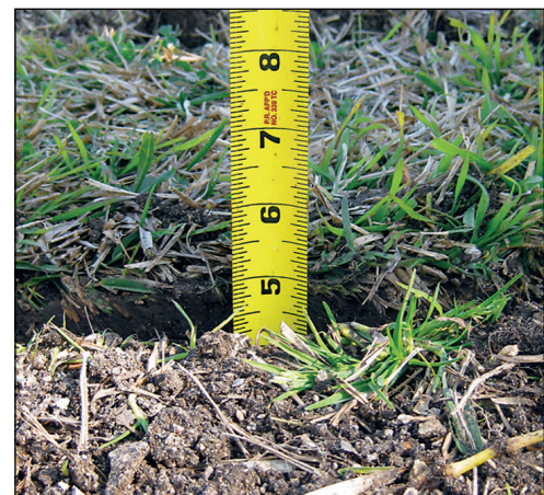
Należy zadbać o to, aby głębokość ułożenia linii kroplującej była stała w całej instalacji
