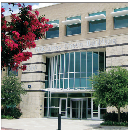
Eliminar a pulverização excessiva em edifícios
