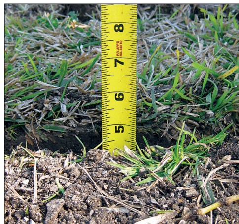
Certifique-se de que a profundidade do tubo gotejador seja uniforme em toda a instalação
