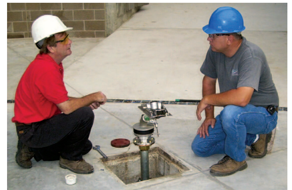
Mike Caldwell y John Kearns llevan a cabo un chequeo de rutina del sistema para mantener un desempeño óptimo de el cañon de Rain Bird.
