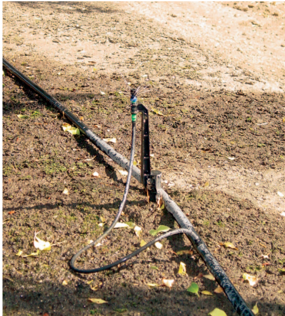
John dice que el diseño del microaspersor Micro-Quick con el pequeño espacio entre el deflector y el orificio de la boquilla es la razón de no tener taponamientos por insectos, ya que “los bichos simplemente no quieren entrar en ese espacio pequeño, y eso me ayuda mucho.”
