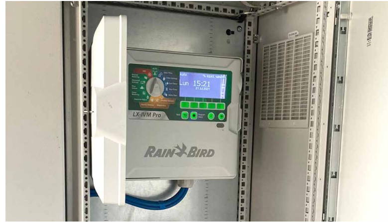
وحدة التحكم ثنائية الأسلاك ESP-LXIVM بتكنولوجيا المحبس الذي
