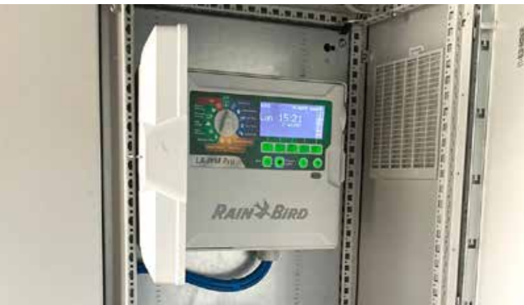
Programador de dois fios ESP-LXIVM com tecnologia de válvula inteligente
