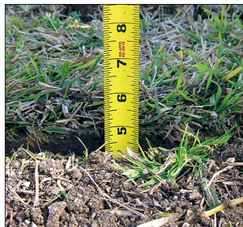
Asegúrese de que la profundidad de la tubería de goteo sea consistente en toda la instalación
