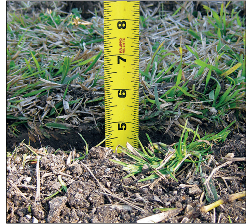
Kurulum boyunca damla sulama borusu derinliğinin eşit olmasını sağlayın
